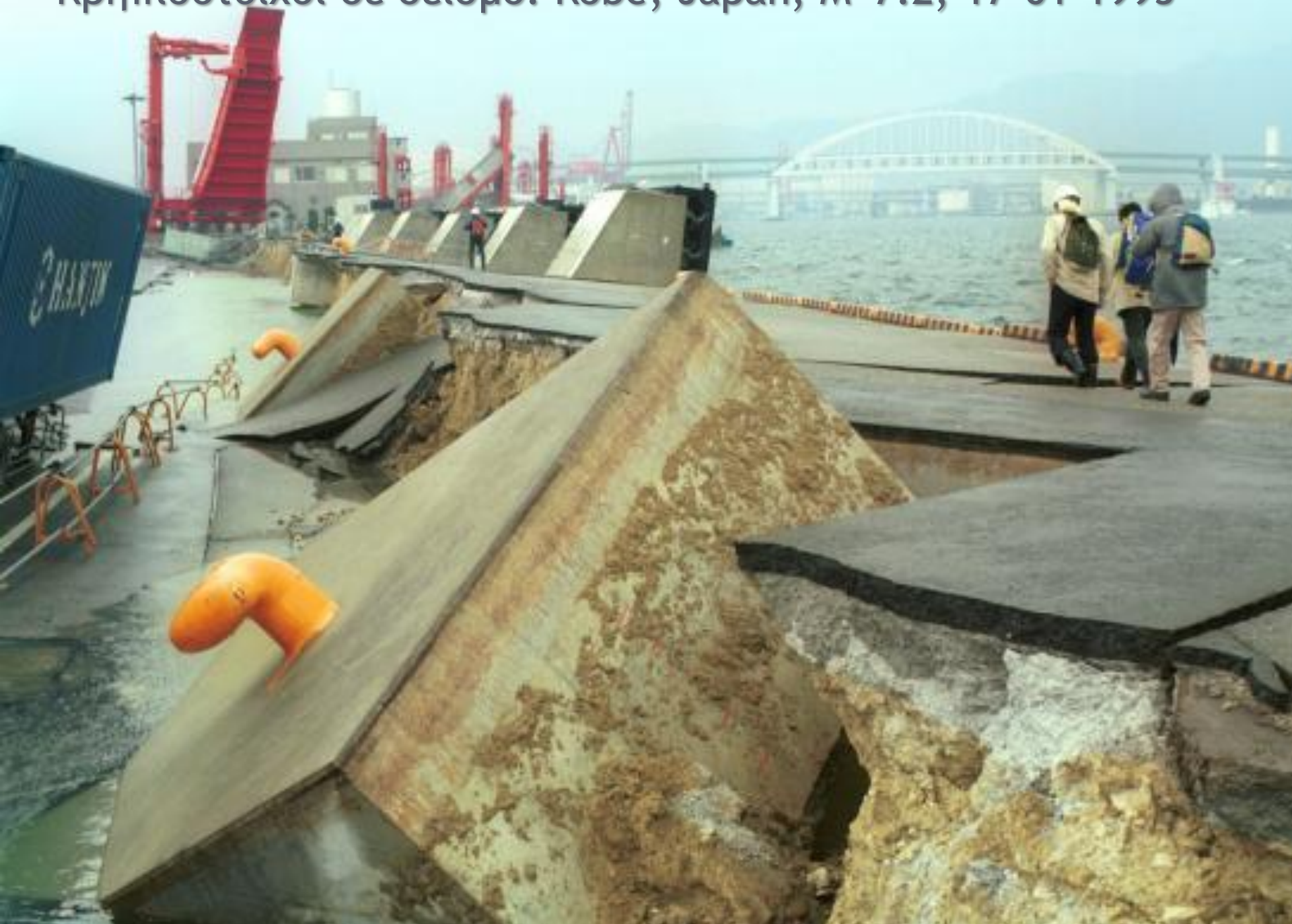
Κρηπιδότοιχοι σε σεισμό: Kobe, Japan, M=7.2 , 17-01-1995
